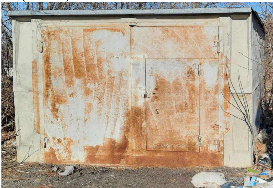
8) Временный железобетонный гараж, размещенный вблизи многоквартирного жилого дома, находящегося по адресу: г. Омск, ул. Богдана Хмельницкого, д. 38/2; (Акт № 131)
