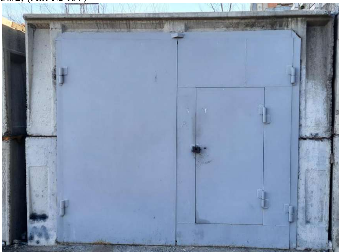
6) Временный железобетонный гараж, размещенный вблизи многоквартирного жилого дома, находящегося по адресу: г. Омск, ул. Богдана Хмельницкого, д. 38/2; (Акт № 129)
