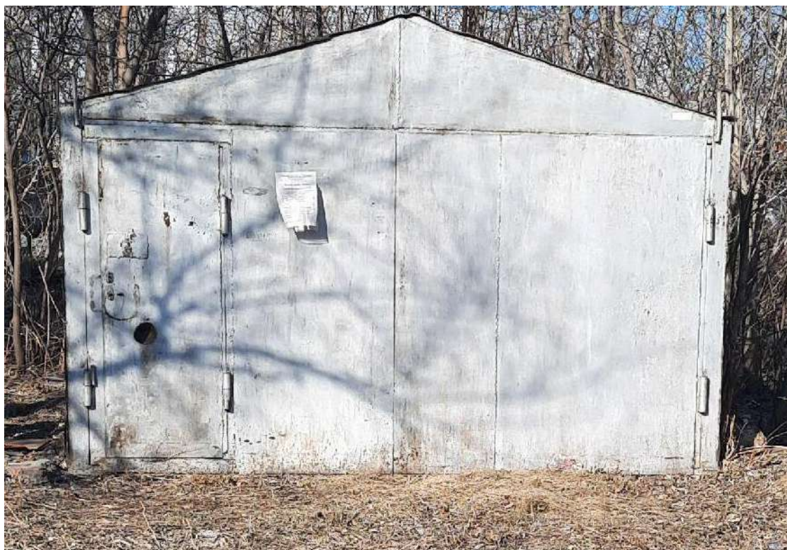
5) Временный железобетонный гараж, размещенный вблизи многоквартирного жилого дома, находящегося по адресу: г. Омск, ул. Богдана Хмельницкого, д. 38/2; (Акт № 137)
