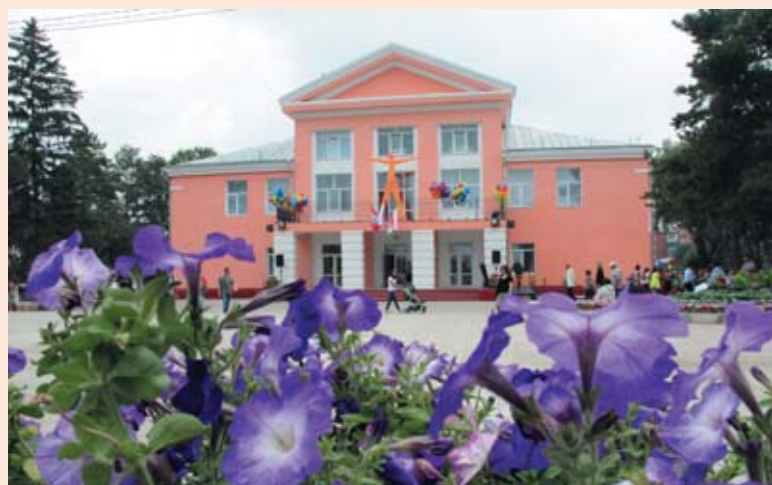
Дворец Кировского округа после ремонта
