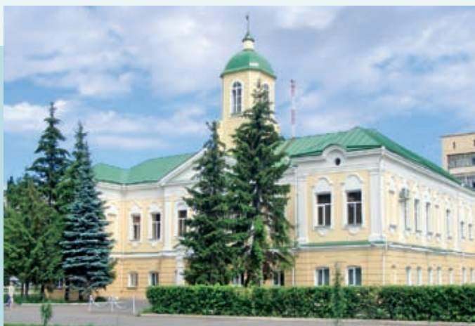
Восстановленное здание гауптвахты
