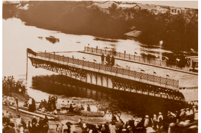
Разводной мост – первый металлический мост через Омь – «парижский». Инженер-строитель – Р. С. Малкин. 1903. Из фондов МИСО
