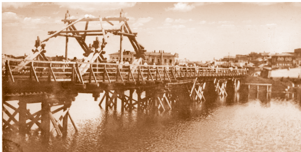
Строительство моста в створе ул. 1-й Взвоз. Начало XX в.
