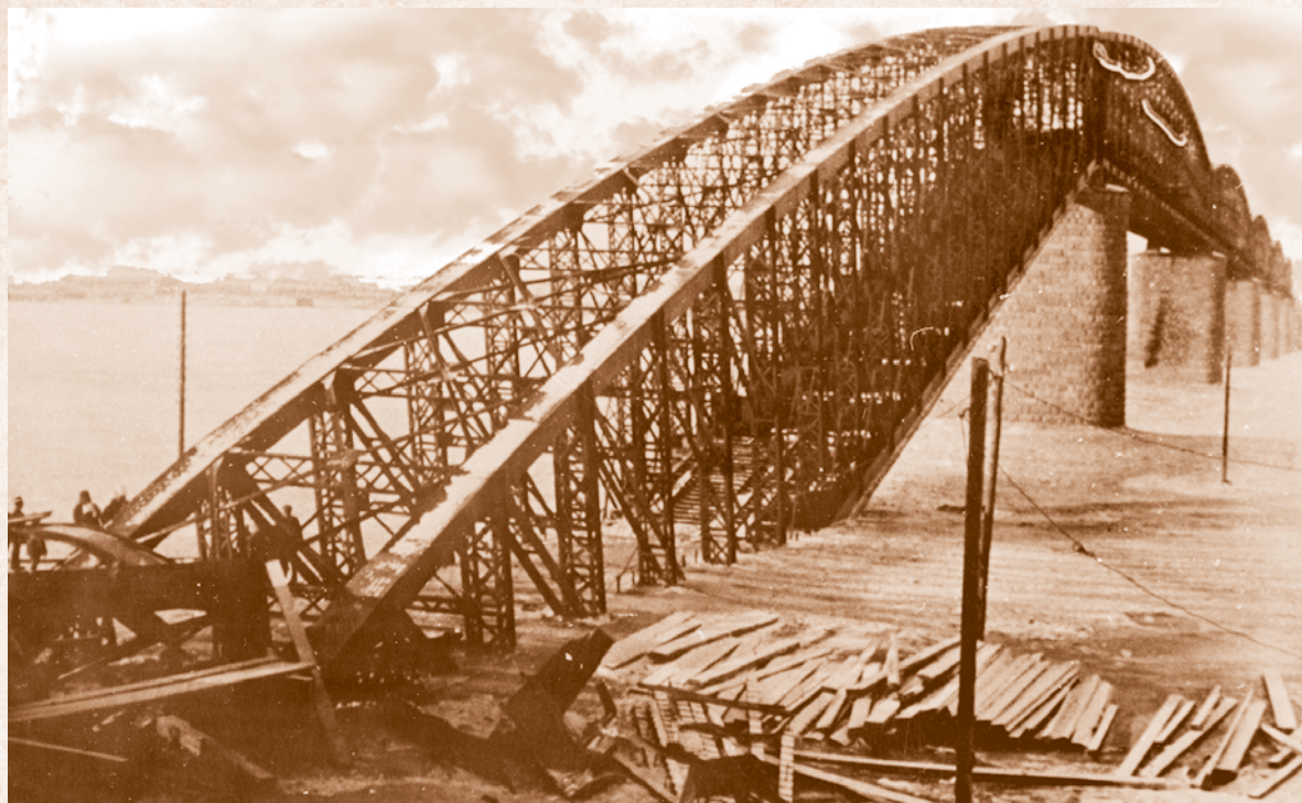
Восстановление взорванного пролета моста через Иртыш. 1919–1920
