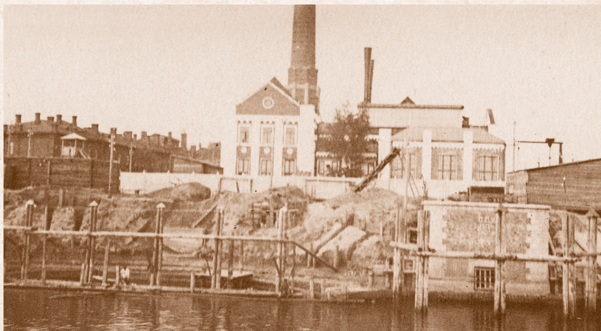
Первая омская центральная электрическая станция 12 . 6 июля 1932 г.
