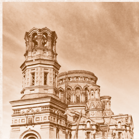
Разрушенное здание Успенского кафедрального собора. 1935
