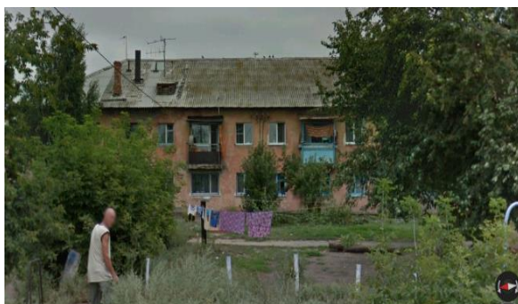
Аварийный жилой дом по ул. 2-я Кировская, 121
