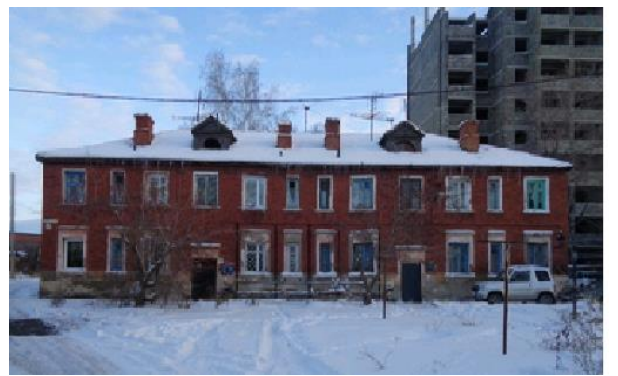
Аварийный жилой дом по ул. 11-я Ремесленная, 23
